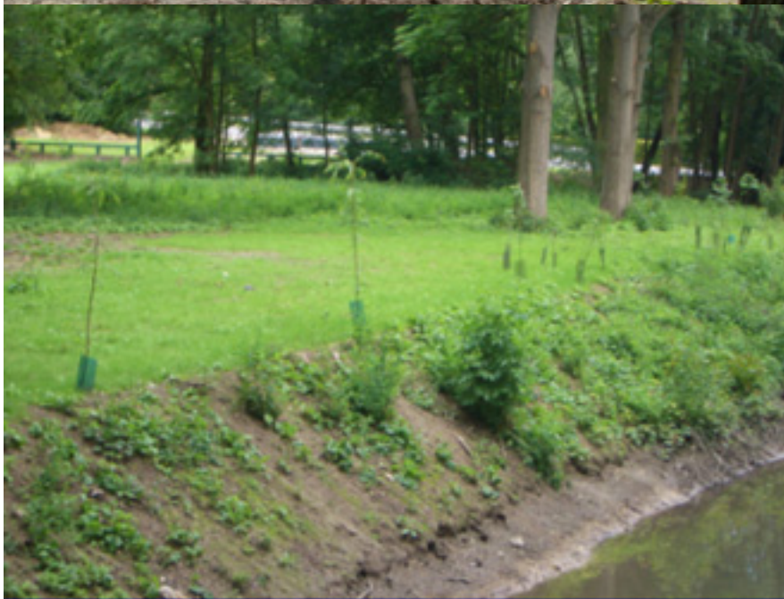
□ Restauration de berges
